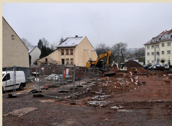
Die Ver- und Entsorgungsleitungen wurden erneuert. In Zusammenarbeit mit dem EVS wurden ein Teil-Hauptsammler sowie eine Regenwasserbehandlungsanlage neugebaut. Für die umliegenden Häuser soll damit die Gefahr vor künftigen Hochwasserereignissen und Überflutungen gemindert werden.
