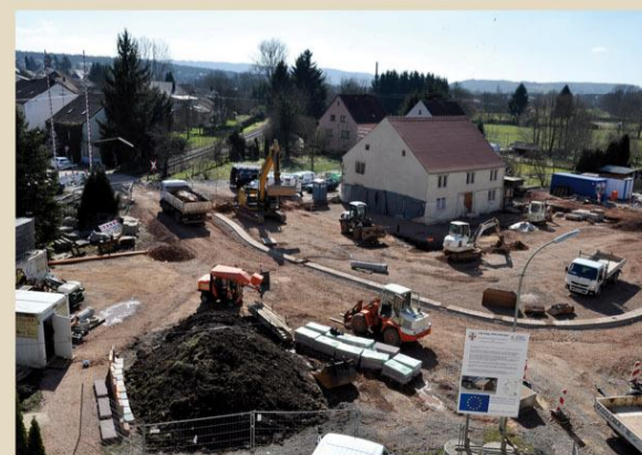
Frühjahr 2015, im Zollhaus ist der Innenausbau in vollem Gange. Auf dem Mitry-Mory-Platz werden die Vorbereitungen für die wassergebundene Decke geschaffen.
