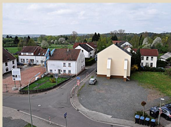
Herbst 2013, die Anwesen Marktstraße. 10, 14, 16 und 18 sowie 30 und der Anbau an das alte Zollhaus wurden bereits abgerissen.
